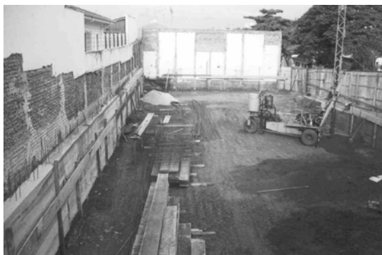
Figura 5. Vista de escavação executada ao longo do muro de arrimo existente.
