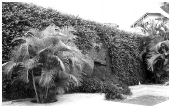
Figura 8. Detalhe da ruptura da parede do muro, provocada pelo acúmulo de água de chuva.
