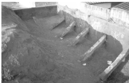
Figura 3. Vista de aterro e muro de arrimo construído adjacente à construção existente.
