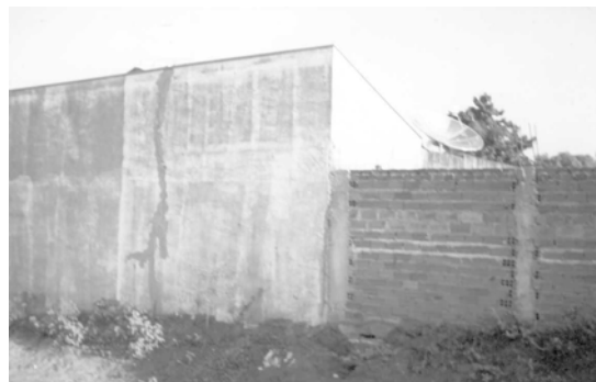
Figura 6. Vista de muro de arrimo construído adjacente à edificação existente sem “folga”.
