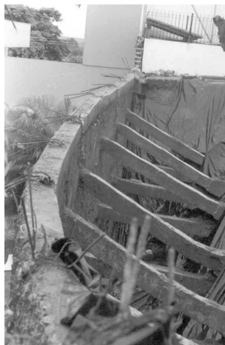
Figura 7. Deformações devido a má drenagem do terreno.
