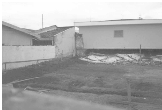
Figura 4. Vista do muro de arrimo que sofreu colapso total.
