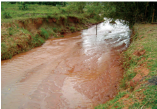
Figura 5.7 – Taludes marginais sujeitos a erosão.
