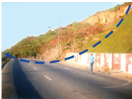
Figura 3.9 – Deslizamento circular ou rotacional.
