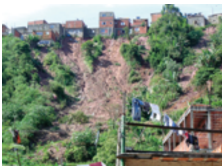
Figura 3.7 – Deslizamentos planares induzidos pela ocupação.
