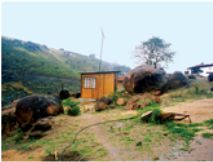
Figura 3.16 – Situação de risco de rolamento de bloco rochoso.
