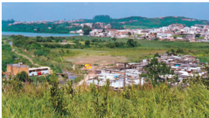
Figura 5.11 – Planície de inundação com ocupação urbana.
